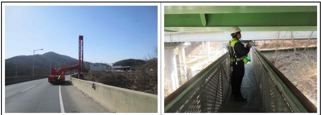
[그림 5.10] 금남IC Ramp-C교 현장조사 현황
